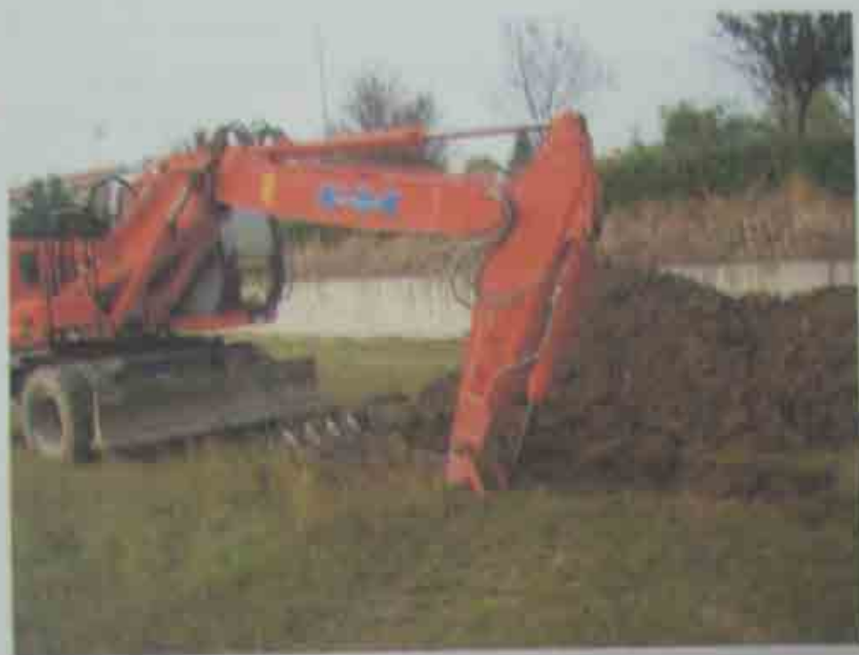
FOTO 3: Operazioni di scavo del pozzetto esplorativo P2.
