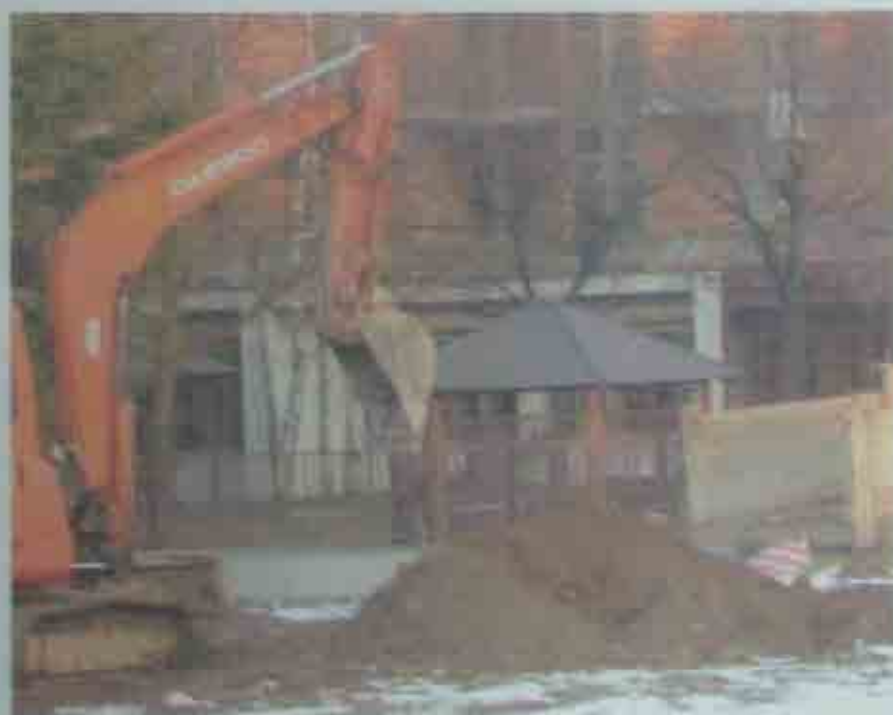
FOTO 2: Materiale di risulta del pozzetto esplorativo P1.
