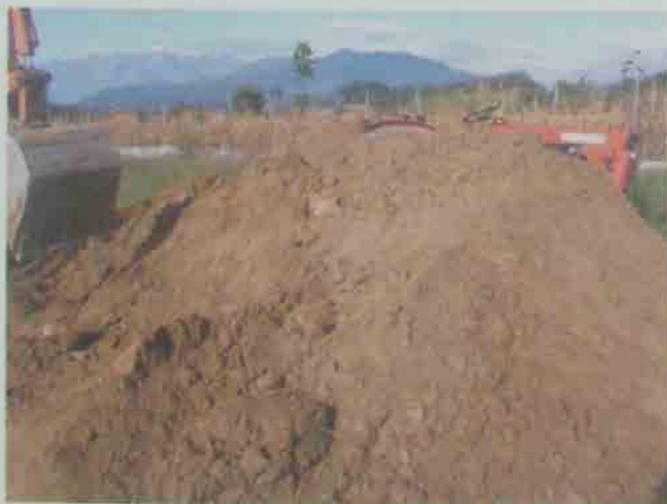
FOTO 2: Materiale di risulta del pozzetto esplorativo realizzato nell'area di intervento.
